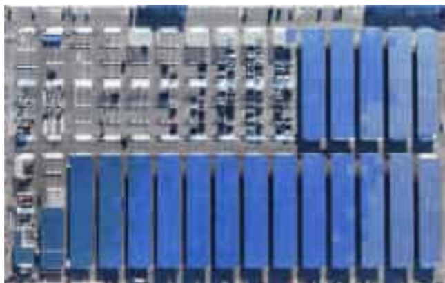
Savannah HMMGA SOLAR POWER, USA 서버너 현대자동차 태양광 공사(미국)
