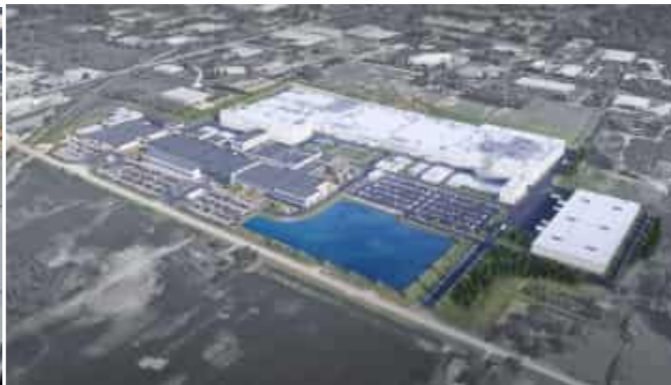
LGES MI2 Data Center, USA 미국 LGES MI2 DATA CENTER
