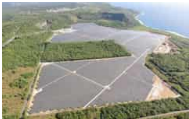
Mangilao Solar Power Plant (60MW) - EPC, USA GUAM 미국 GUAM Mangilao 태양광 설비(60MW) - EPC
