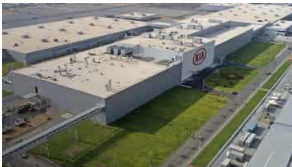
Kia Motors Data Center, India 인도 기아자동차 DATA CENTER
